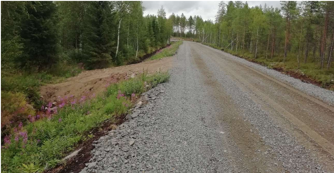
KUVA 29. Esimerkki toteutetusta tuulivoimalapuiston sisäisestä tiestä. Teitä rakennetaan liittymät metsäpalstoille.
