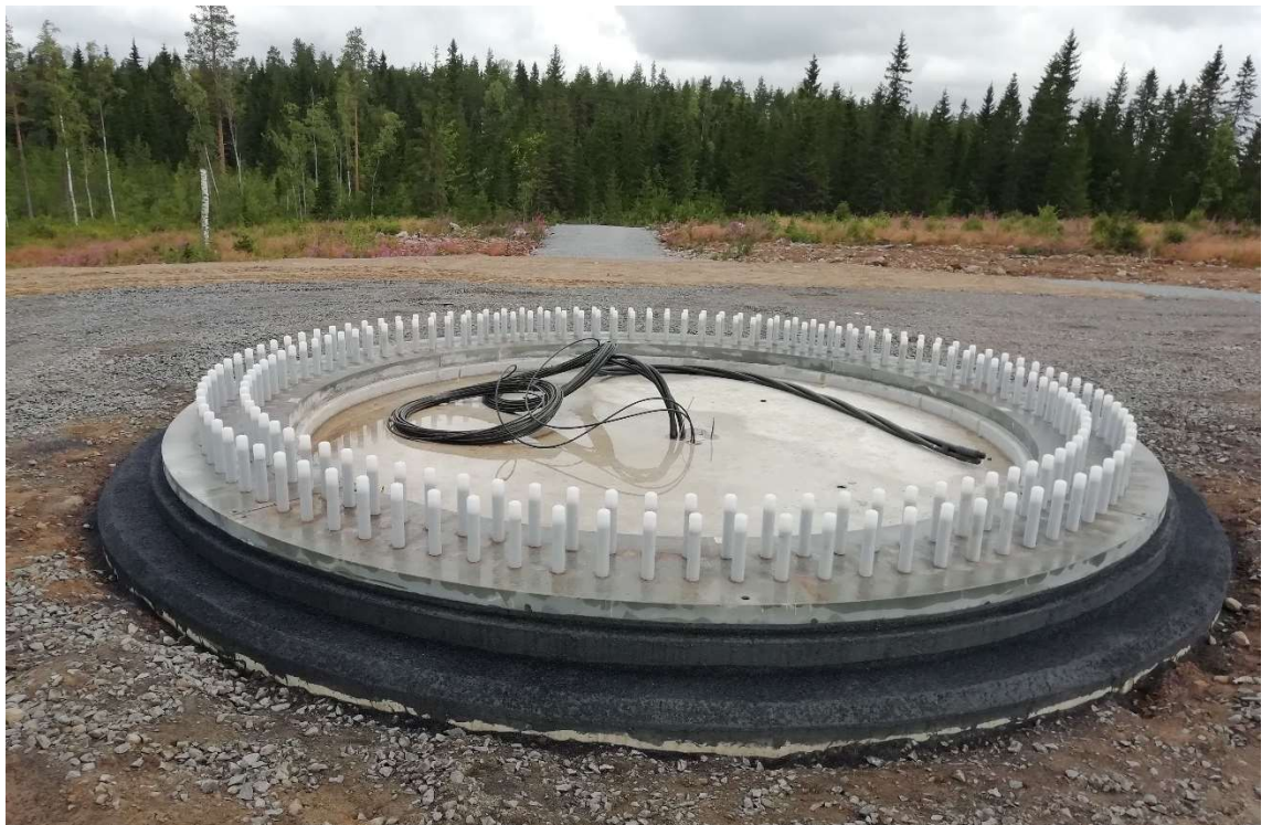
KUVA 28. Toteutettu esimerkki perustuksen maanpäällisestä osasta
